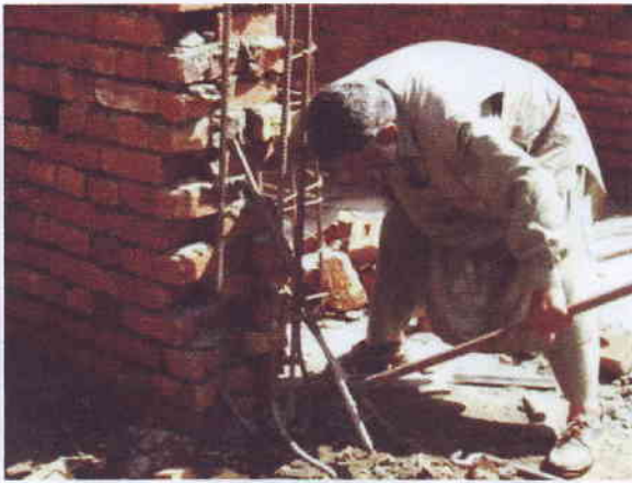
Afghanische Bauarbeiter bei Techniken, die für die ganze Region im Bau ganz innovativ sind. Alles nur Handarbeit, praktisch ohne Baumaschinen!
